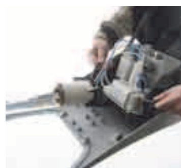
Способ демонтажа электрической оснастки
